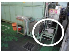
スチームドレンをタンクに貯め一定量が貯まったところで○印内のポンプで排水側溝まで自動排水出来る様にした。これにより、熱水が貯まったタンクを手搬送する作業が無くなった。
