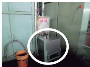
スチームドレン水は、まず上のタンクに貯め一定量溜まったところで、ハンドバルブを開けて下のタンクにドレン水を移した後、手搬送で50m程度離れた排水側溝まで作業者が定期的に行っていた。
