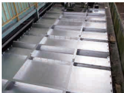
塗装後上部外観
