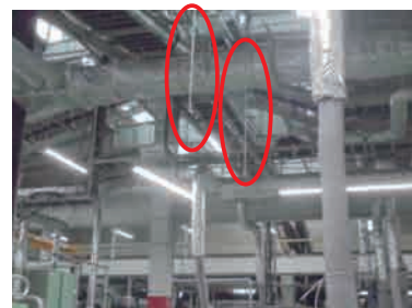
(事例)高所設備の落下防止
