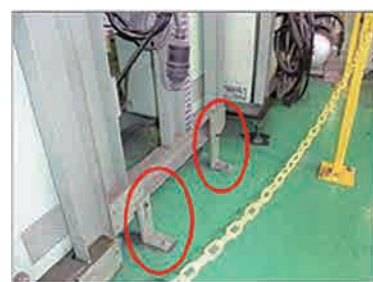
(事例)設備のアンカー固定
