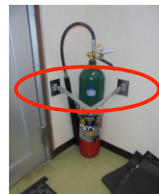
(事例)消火器転倒防止
