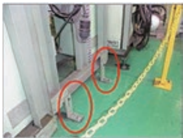
(事例)設備のアンカー固定
