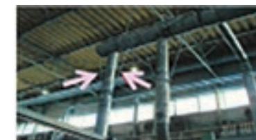
(事例)ダクトの落下防止
