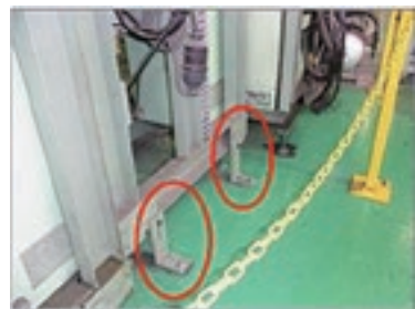
(事例)設備のアンカー固定
